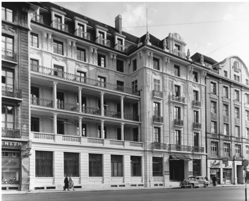
First BIS building, the Savoy Hôtel Univers, Basel, 1930–1977
