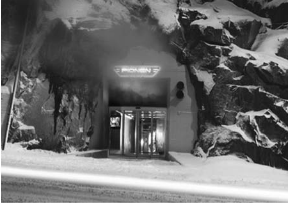
Figure 3.6. Bahnhof data center, Stockholm, Sweden.
